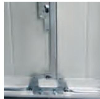
**Exclusivité et sécurité optimale :** les portes basculantes sont équipées d'un système de verrouillage exclusif en deux points latéraux pour une sécurité renforcée.
